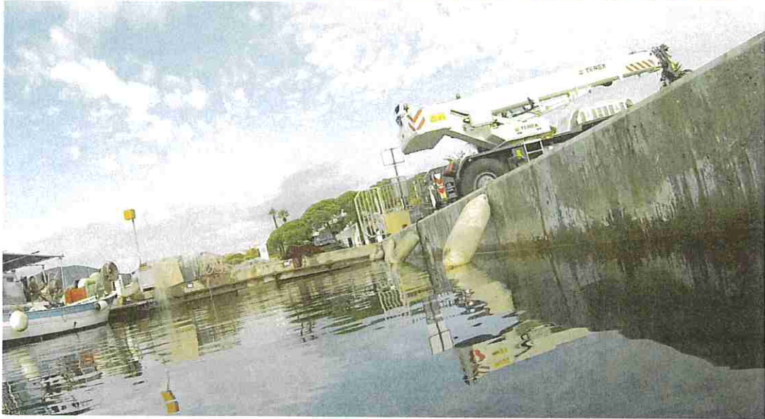
Vue 2 : Aire de carénage vue de gauche et de face (10/10/2022)
